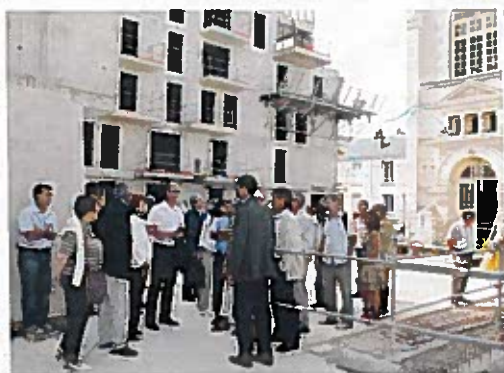
Sur le chantier des Bastions. Nous sommes à deux pas des Halles et du Botanique.
